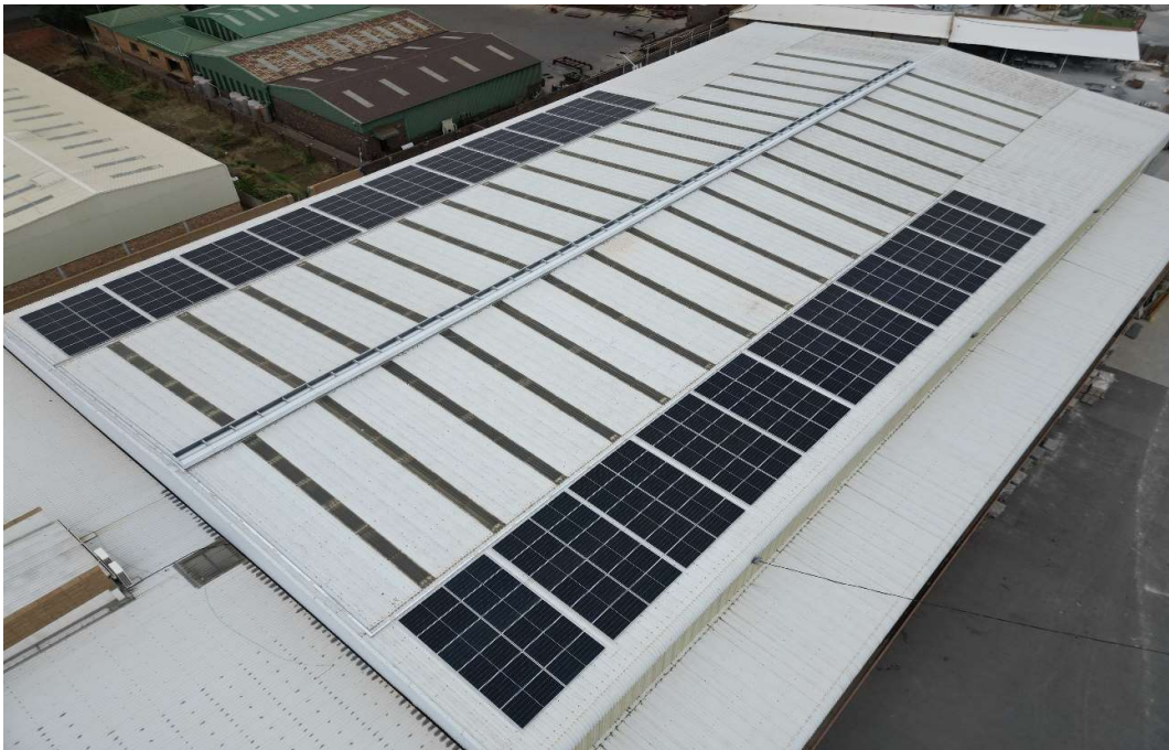
252 x JA SOLAR (JAM72S30-565W/LR) Panels
